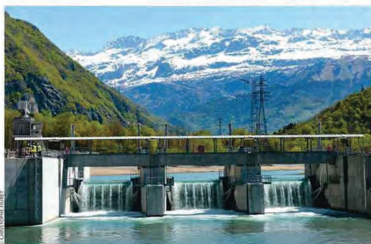
Le nouveau Barrage Romanche-Gavet sera mis en service en 2020
