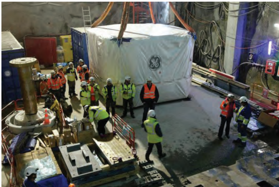
Visite de chantier. © EDF – C. Huret
