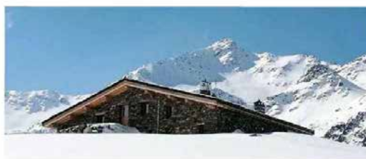
Nouveauté de l'hiver, les portes du refuge de Terre Rouge (2 182 mètres), jadis accessibles uniquement l'été, ouvrent dès janvier, aux randonneurs (raquettes ou ski), et aux sorties accompagnées à la journée avec pause déjeuner.
