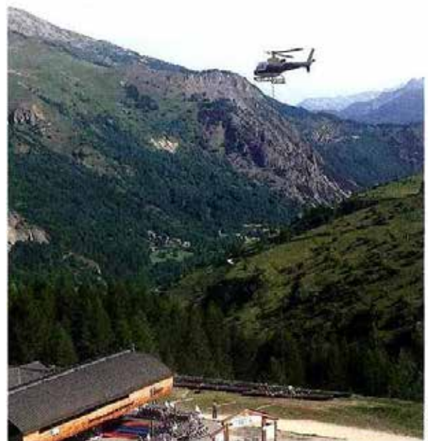
Une partie des matériaux (ici, pour la construction d'une conduite d'eau) doit être transportée par hélicoptère.
