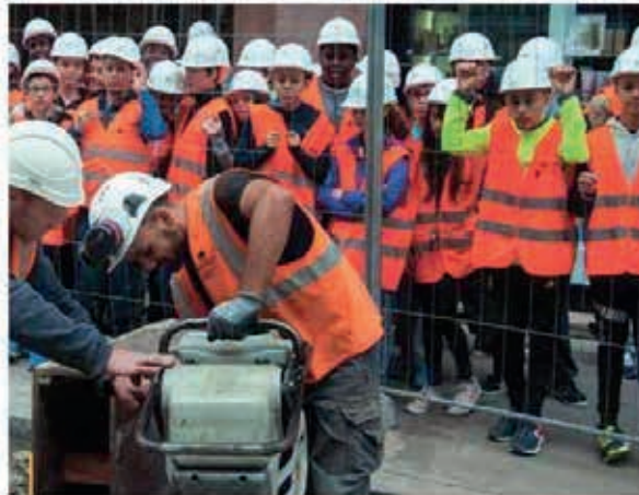
Les élèves de 4 ème du collège du Tonkin de Villeurbanne sur le chantier de la ligne C3
