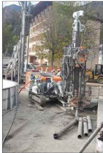
À la fin du mois d'octobre, le chantier battait son plein.
